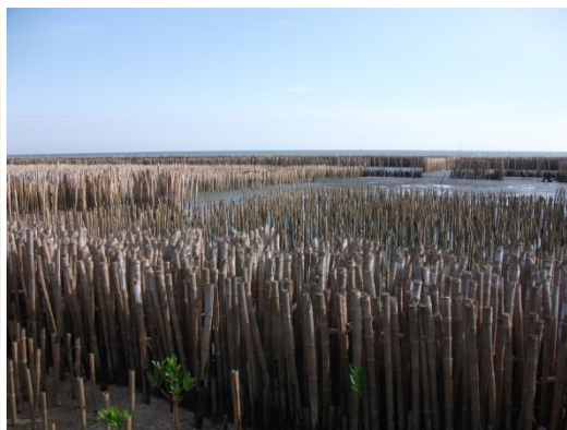
รูปที่ 2: แนวไม้ไผ่ชะลอคลื่นที่ชาวบ้านร่วมกันสร้าง ที่มา: ผู้วิจัย
