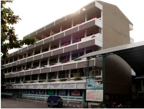
รูปที่ 1 ลักษณะอาคารโรงเรียนที่ก่อสร้างจริง
